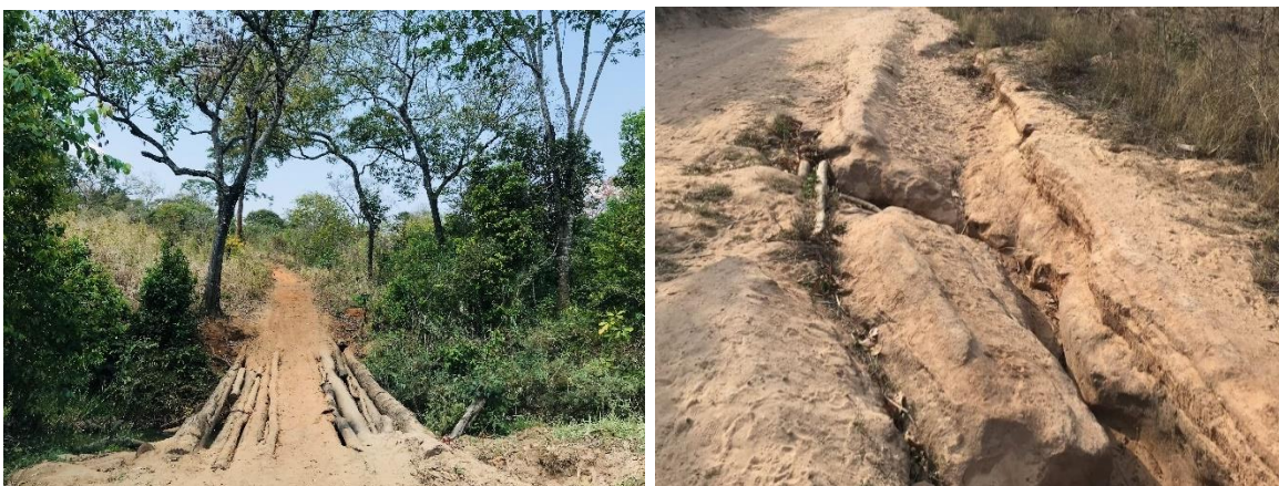
Figura 8. Vias de acesso
